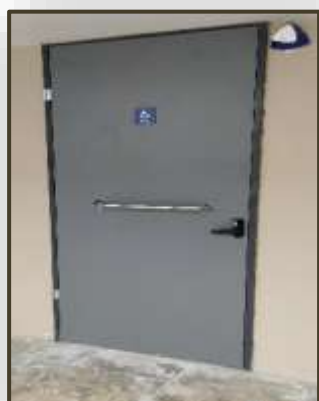
Εικόνα 182. Πόρτα με πόμολο και μπάρα (1° ΕΠΑ.Λ. Κέρκυρας)
