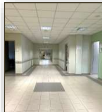
Εικόνα 52. Διάδρομος με αντιολισθητικά πλακίδια και μπάρες στήριξης (Ε.Ε.Ε.ΕΚ. Ηρακλείου Αττικής)
