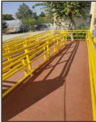
Εικόνα 61. Ράμπα από αντιολισθητικό υλικό (Ε.Ε.Ε.ΕΚ. Βόλου)
