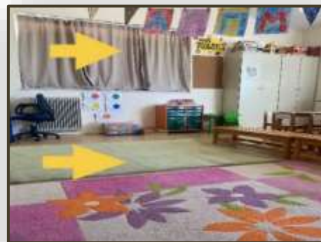
Εικόνα 155. Κατάλληλα υλικά για τη μείωση θορύβων (Ειδικό Νηπιαγωγείο Κωφών και Βαρηκόων Πάτρας)
