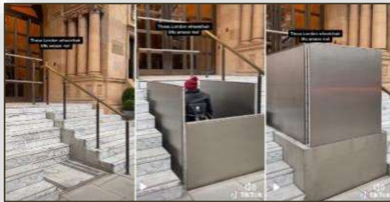
Εικόνα 20. Αναβατήριο με πλατφόρμα βυθιζόμενη στο πεζοδρόμιο, για πρόσβαση στην είσοδο (Δημουλά, κ.ά., 2023)
