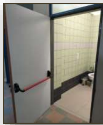
Εικόνα 183. Πόρτα με μπάρα (3° Δημοτικό σχολείο Αμυνταίου Φλώρινας)
