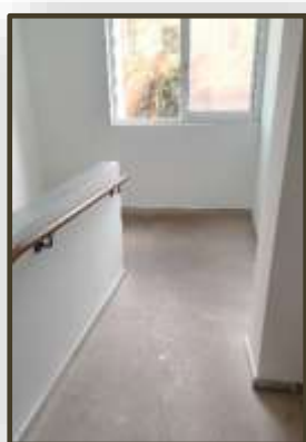
Εικόνα 54. Επικλινής διάδρομος με μπάρα στήριξης (1 ο Ειδικό Δημοτικό σχολείο Χανίων)
