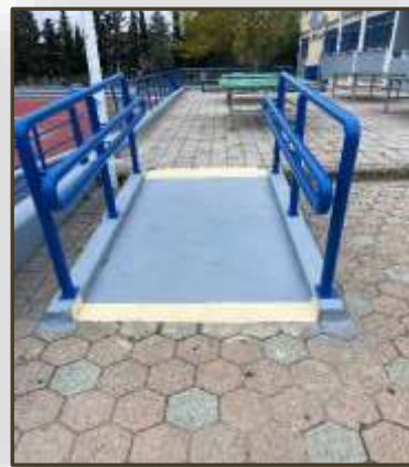
Εικόνα 17. Ράμπα με διπλούς χειρολισθήρες (5 ο Γυμνάσιο Ξάνθης)
