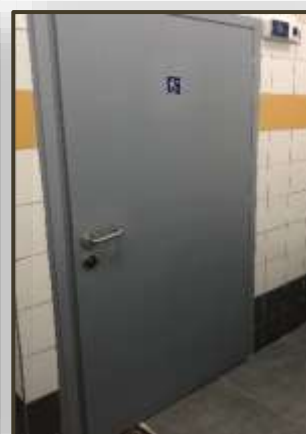
Εικόνα 186. Πόρτα με πόμολο (1 ο Νηπιαγωγείο & 3 ο Νηπιαγωγείο Κατσικά Ιωαννίνων)
