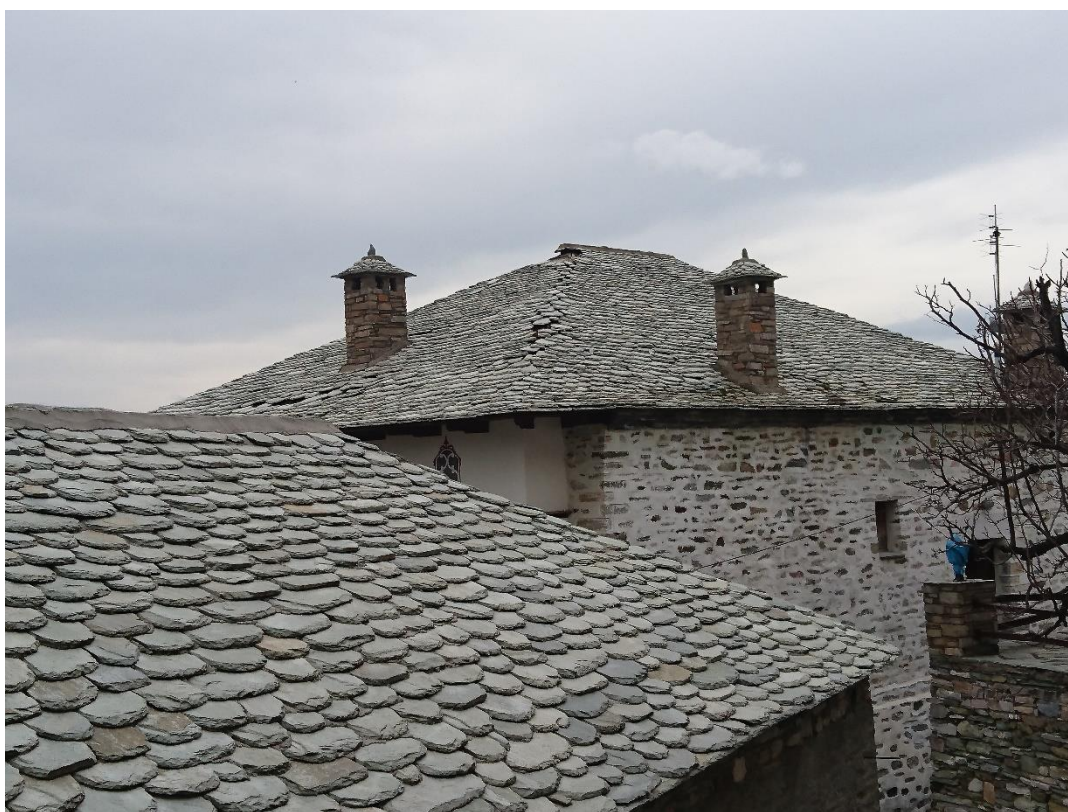
Μετακίνηση των πλακών Πηλίου της επιστέγασης, στο βορειοανατολικό μαχιά, την ανατολική άκρη του κορφιά και την ανατολική επιφάνεια της στέγης.
