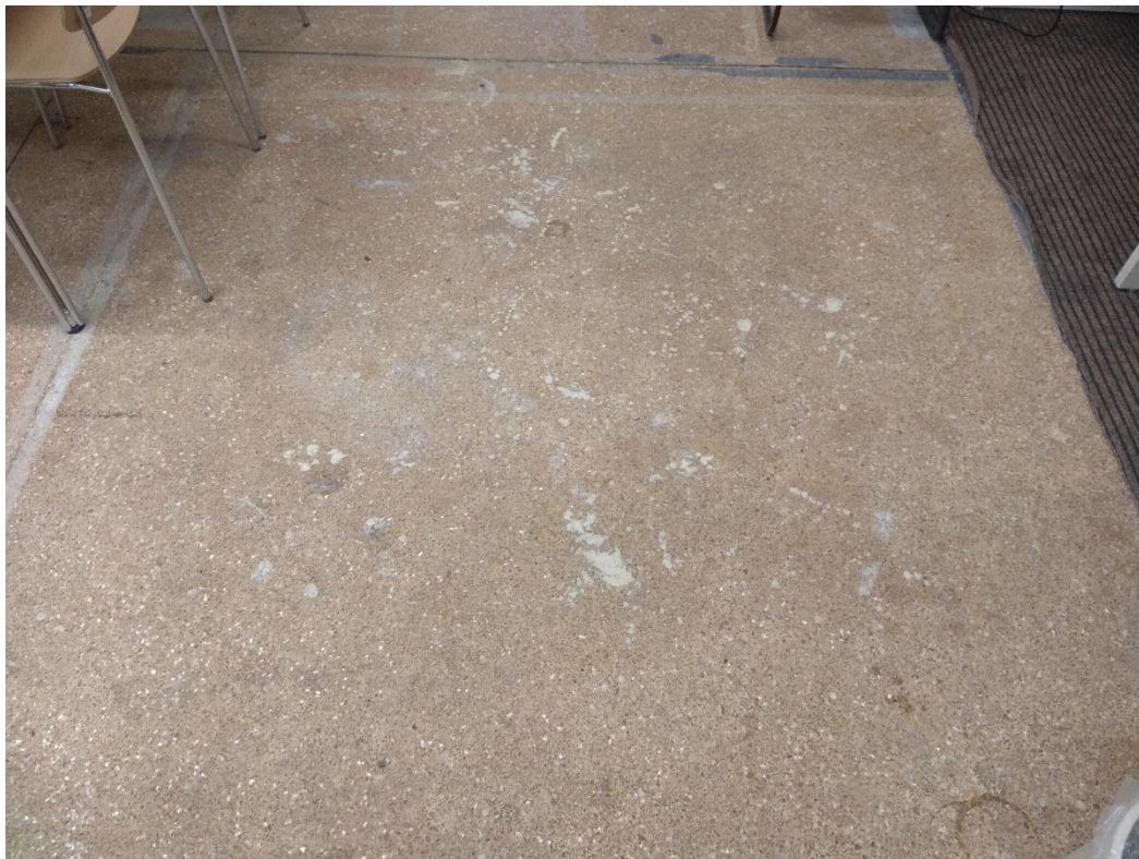
Φθορά του μωσαϊκού δαπέδου στην αίθουσα διαλέξεων της Δημόσιας Κεντρικής Βιβλιοθήκης Ναυπλίου.
